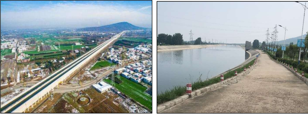
图2-6 南水北调干渠现状图
