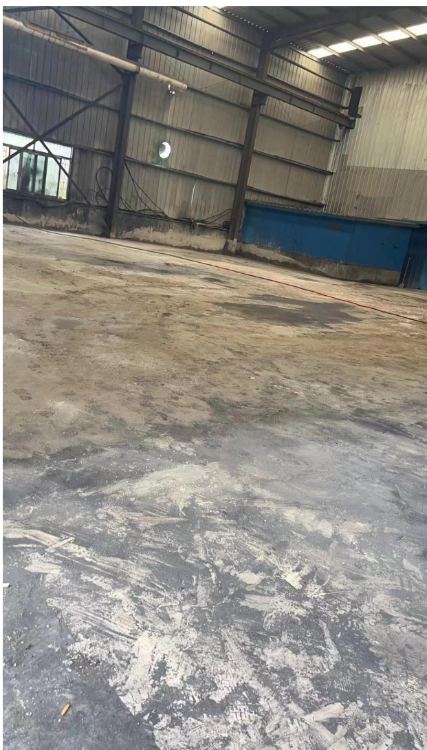
项目租赁厂房内部照片（1）
