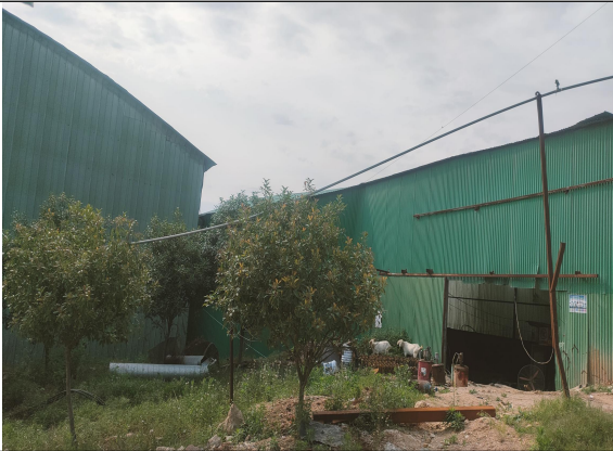
项目西侧现状
