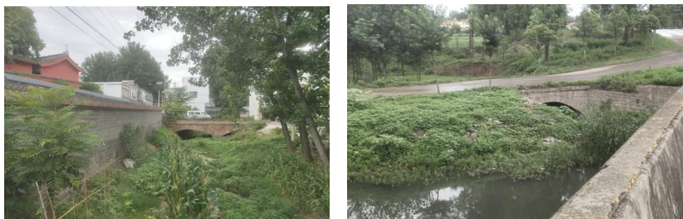
图 1.2-2 农村水系河道水域岸线侵占
