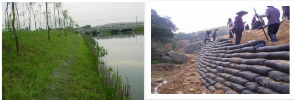
土工袋护坡技术-土工织物扁袋效果图
