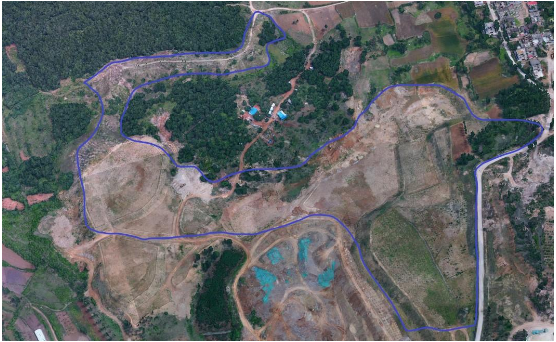
图 2-5 勘察区 1 地形地貌（镜头朝向 67°）
