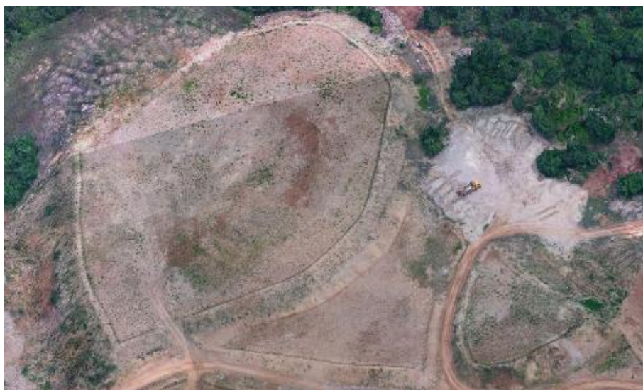
图 3-1 勘查区 1 已初步治理完成的平台（镜头朝向 126°）
